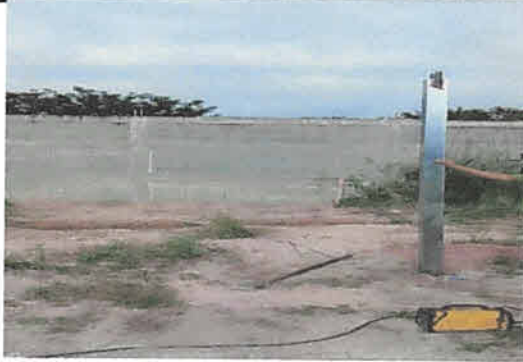
Foto 1: Elaboración de la estructura para la nueva galera
