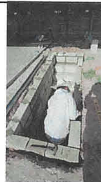
Foto 4: Elaboración de la fosa para uso de taller
