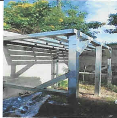
Foto 2: elaboración de estructura metalica para tinaco
