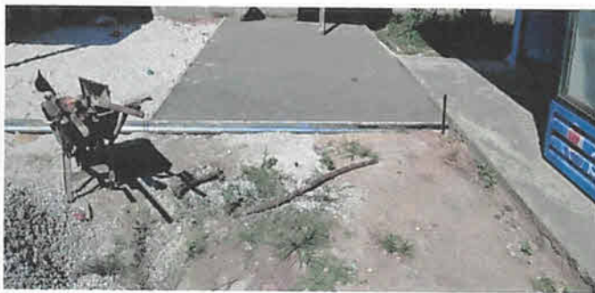
Foto 5: Elaboración de Torta de concreto de 8cms de espesor, 75 m2
