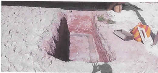
Foto 3: Elaboración de sanja para fosa, uso de taller
